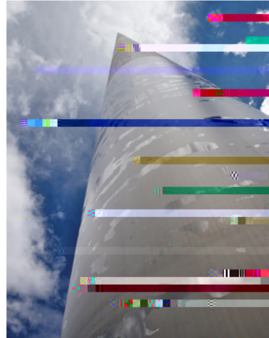
Le Dublin Spire - un exemple frappant de notre technique de texturation de surface montrant la polyvalence de grenaillage contrôlé
